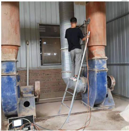
车间排气筒采样现场
